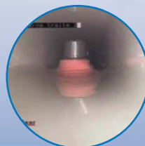
Canalisation propre après six semaines de mise en service
